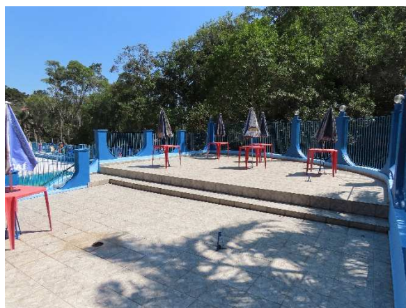
FOTO 04 – Vista do deck da piscina, cujo atendimento é feito do público é feito através de balcão existente entre o bar e o local
