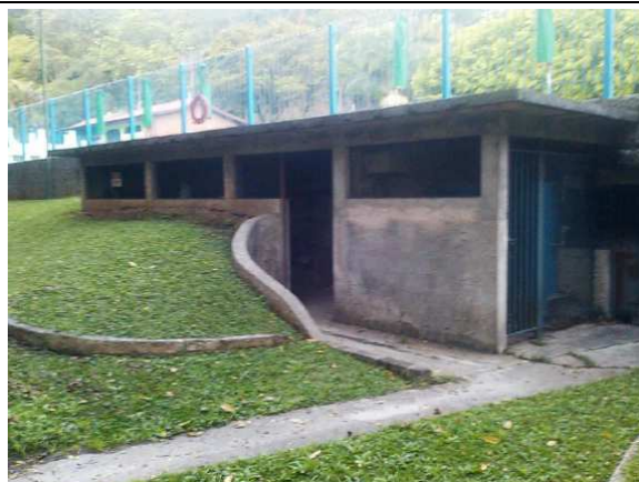
Foto 02 – Vista do atual abrigo onde está instalado o filtro das piscinas e local onde existiam os cilindros de GLP utilizados para aquecimento das piscinas.
