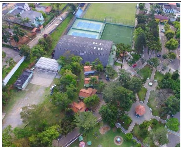
Foto 05 – Foto aérea do ginásio poliesportivo e de área em solo, opções para instalação das placas fotovoltaicas.
