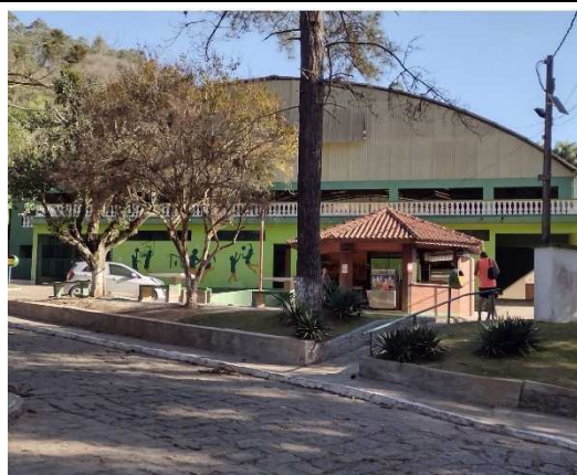
Foto 03 – Vista da fachada do ginásio poliesportivo, sombra registrada às 15h48min.
