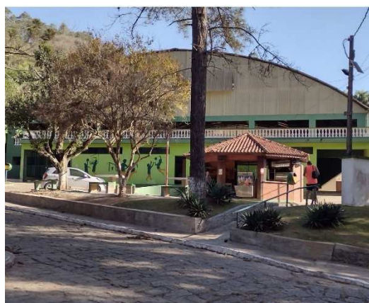
Foto 02 – Vista da fachada do ginásio poliesportivo, sombra registrada às 15h48min.
