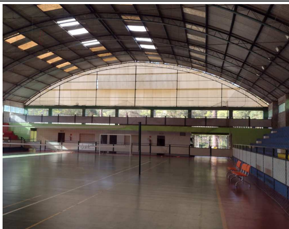
Foto 07 – Foto interna do ginásio poliesportivo, onde é possível visualizar a estrutura do telhado.
