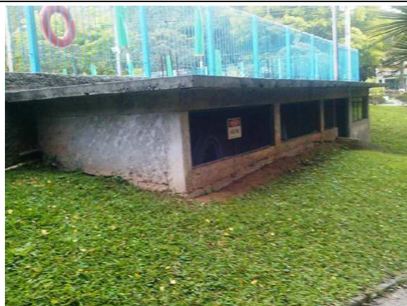
Foto 01 – Vista do atual abrigo onde está instalado o filtro das piscinas e local onde existiam os cilindros de GLP utilizados para aquecimento das piscinas.
