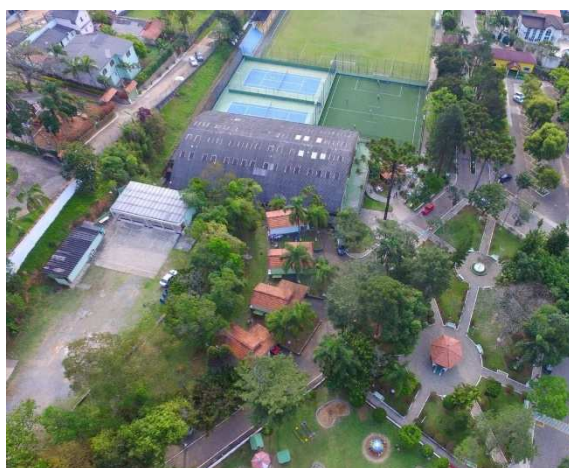
Foto 03 – Foto aérea do ginásio poliesportivo e de área e solo, opções para instalação das placas fotovoltaicas.
