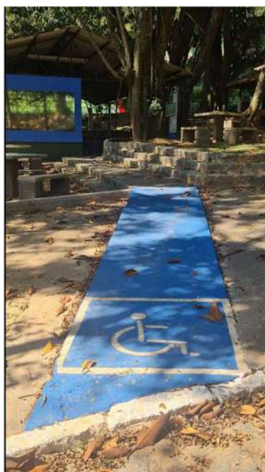
Imagem: Rampa acessibilidade com degrau para acessar
