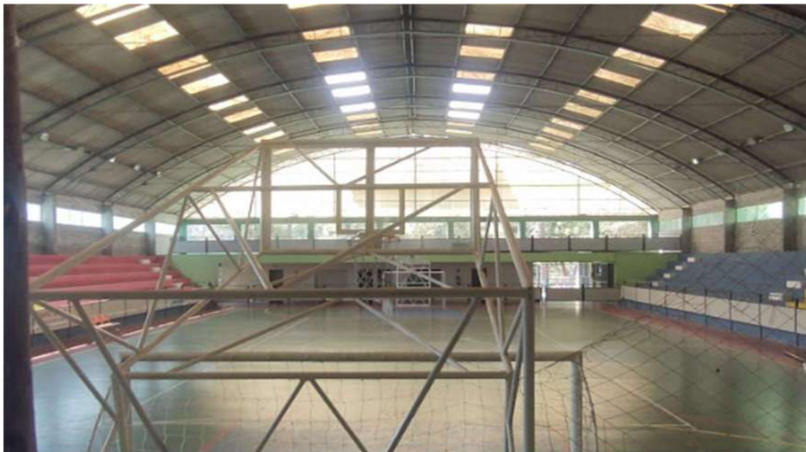
Imagem: Vista interna ginásio poliesportivo
