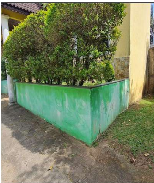
Imagem Exterior - desgaste pintura e umidade
