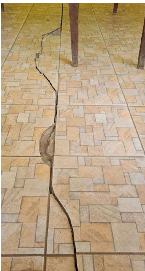
Imagem: Piso trincado de quiosque
