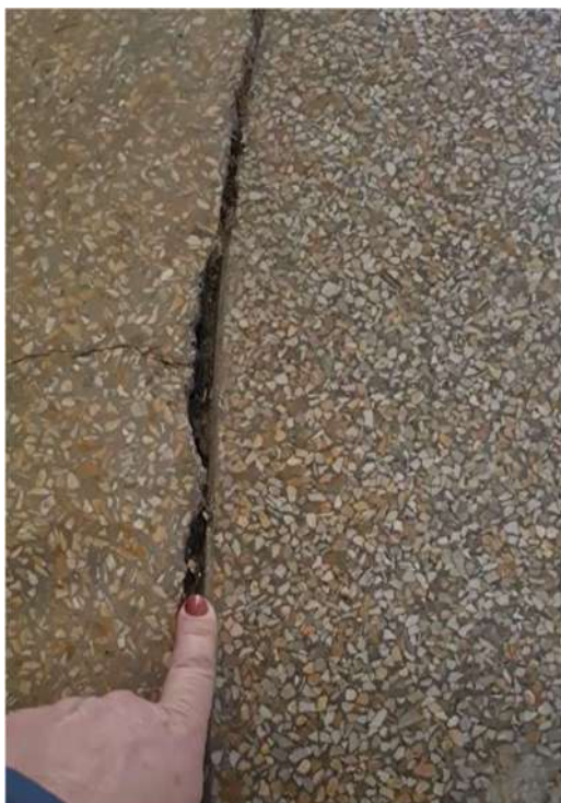
Imagem: Rachadura no piso
