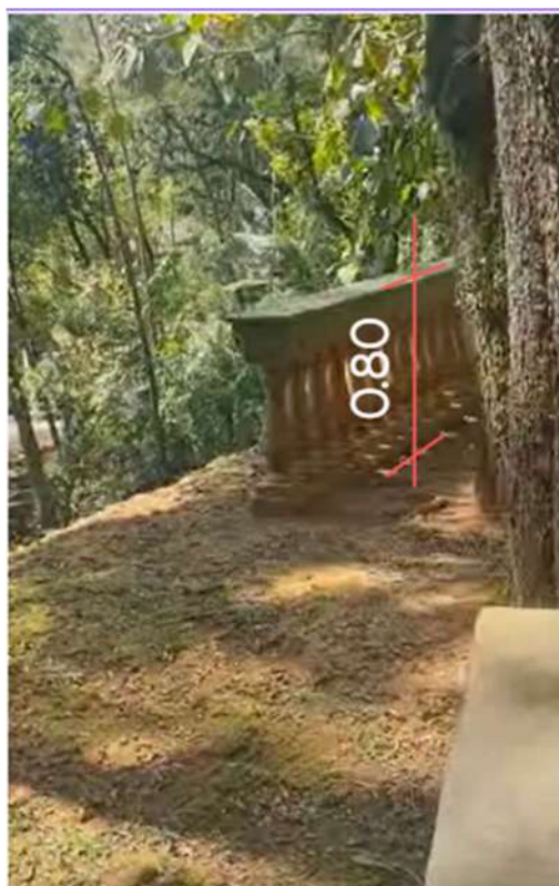
Imagem: Balaústre/ Guarda corpo altura menor
