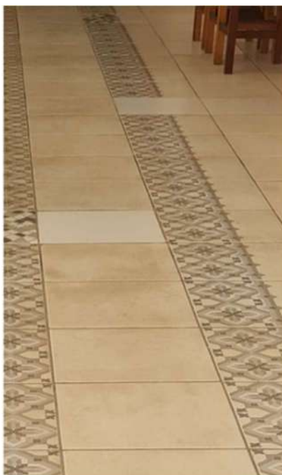
Imagem: Piso manchado – identificadas mais de 20 peças com som cavo ao teste de percussão
