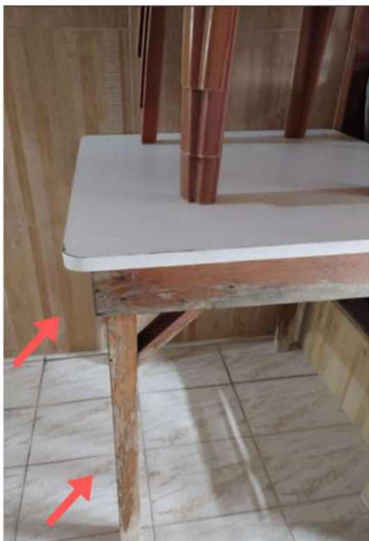
Imagem: Mobiliário funcional e desgastado
