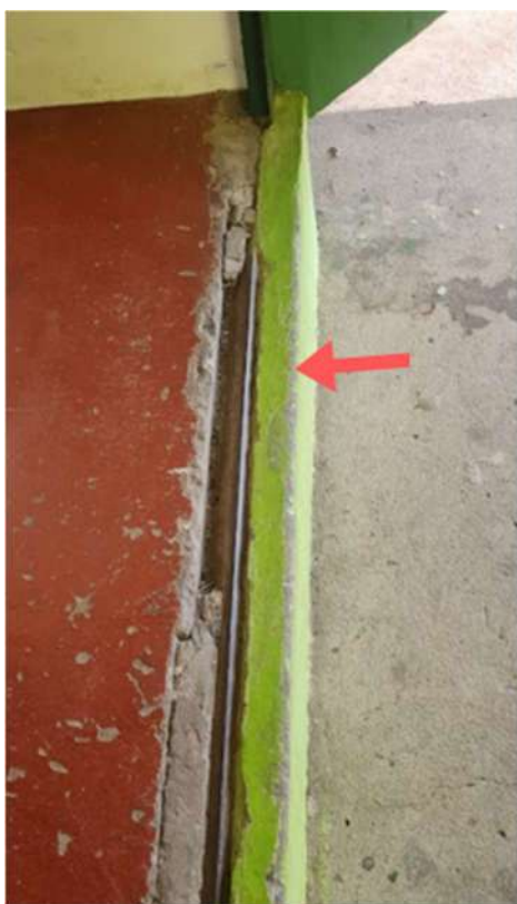
Imagem: Base do portão de correr muito danificado, abertura comprometida
