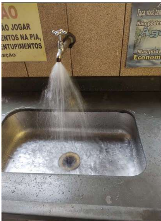
Imagem: torneira mal instalada – cai água na pia Baldes para coleta de lixo – sem tampas
