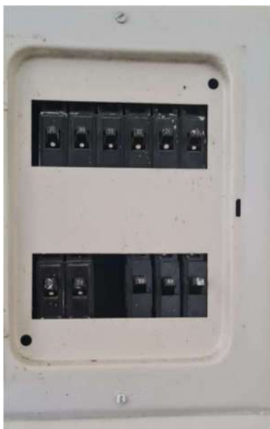
Imagem: Quadro forças adequado, porém não identificados
