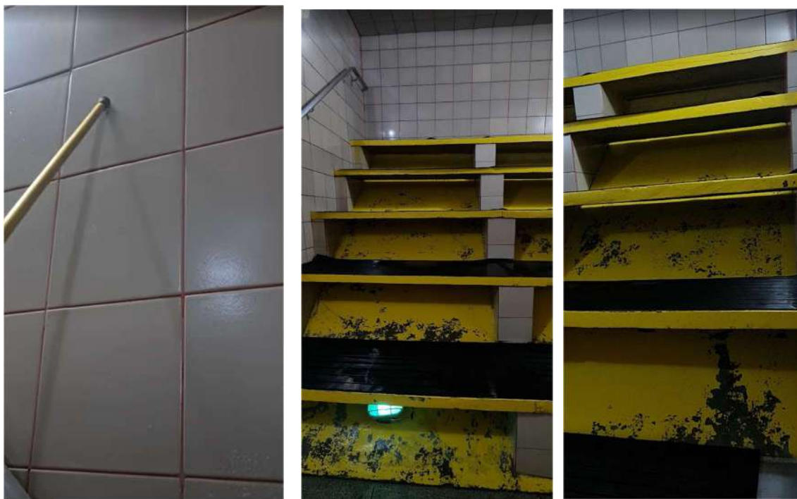
Imagem: Revestimento com som cavo
