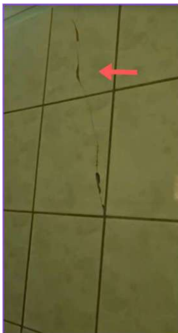
Imagens: Revestimento trincado Espelho desgastado
