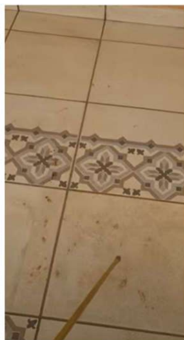
Imagem: Piso manchado – identificadas mais de 20 peças com som cavo ao teste de percussão
