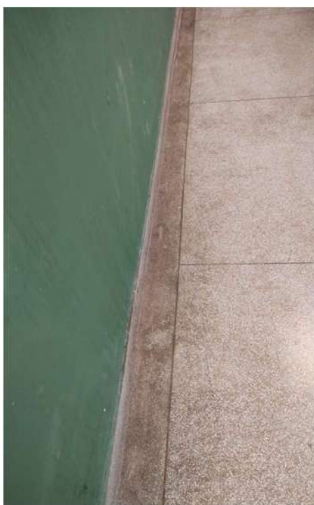
Imagem: Piso e parede manchados
