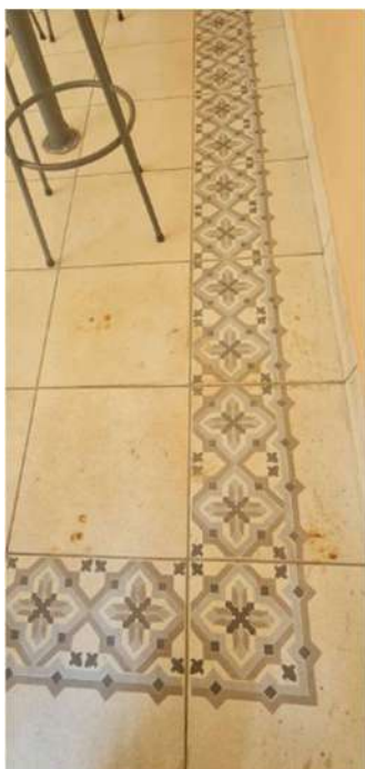
Imagem: Piso manchado – identificadas mais de 20 peças com som cavo ao teste de percussão
