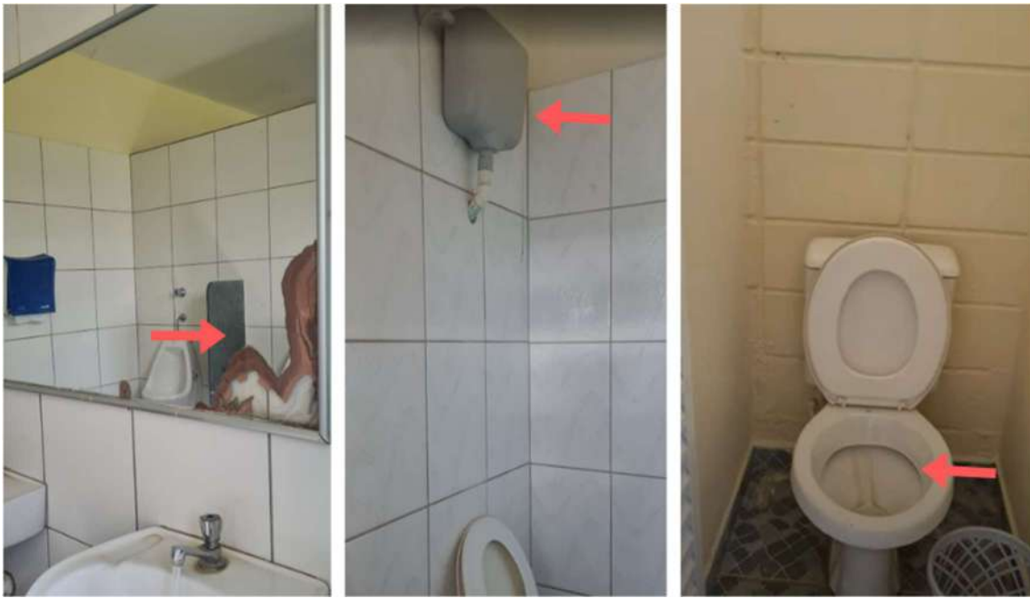
Imagem: Espelho desgastado pelo tempo, válvula descarga – modelo antigo
