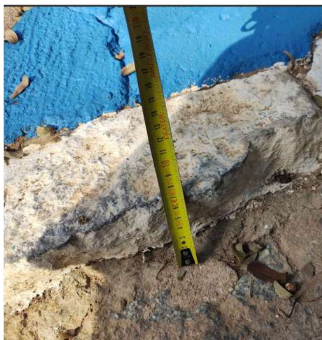
Imagem: Rampa acessibilidade com degrau para acessar
