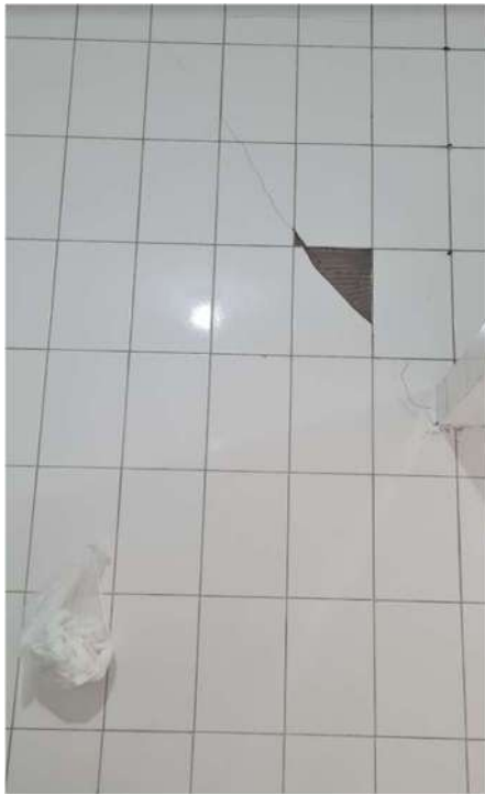
Imagem: Revestimento trincado na cozinha Imagem: Piso necessita manutenção
