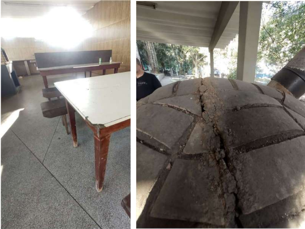
Imagem: Quiosque de pizza – mobiliário Forma danificada
