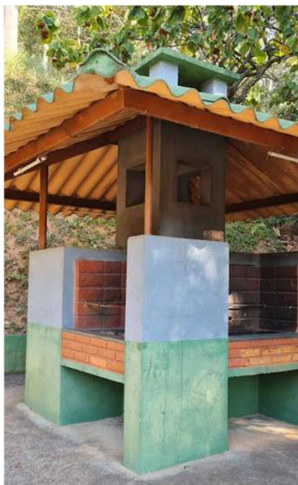
Imagem: Quiosque dos chalés – perfeito estado de conservação
