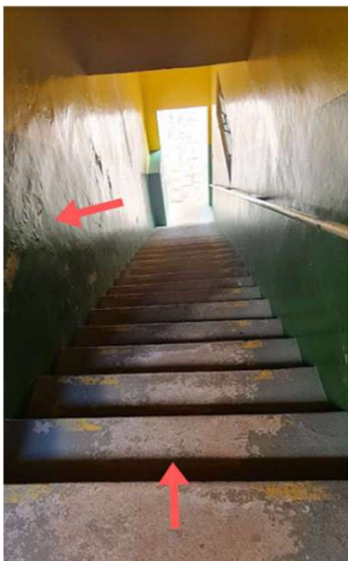
Imagem: Acesso a aptos – pintura danificada e muita umidade nas paredes
