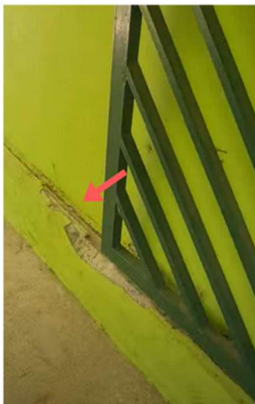
Imagem: Base do portão de correr muito danificado, abertura comprometida
